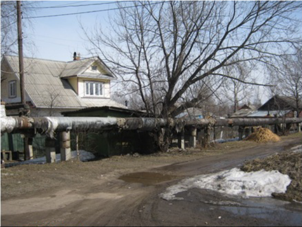
Фото 1.13.1 – Участок теплосети, отвод на ул. Ломоносова. Состояние тепловой изоляции – неудовлетворительное.
