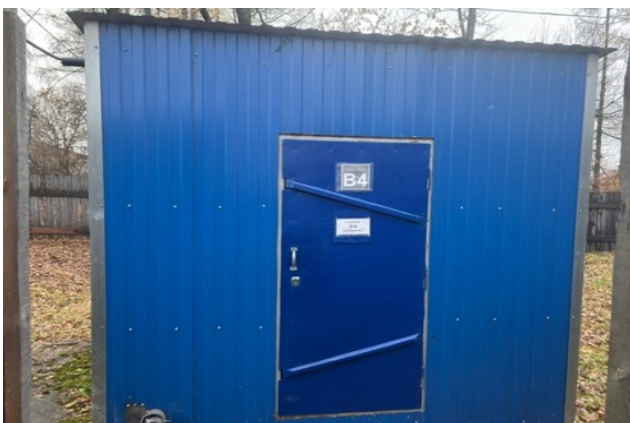
Рисунок 6.4.18 – Павильон скважины ул. Пушкина
