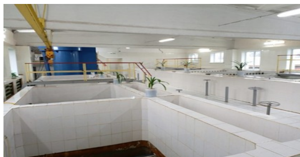
Рисунок 6.4.14 – Фильтры и осветлители НФС
