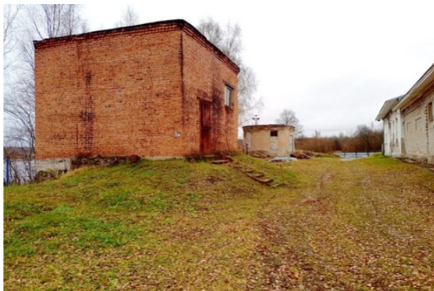
Рисунок 6.4.1 – Здание водозаборной станции
