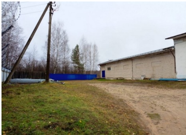
Рисунок 6.4.5 – Здание новой НС-1
