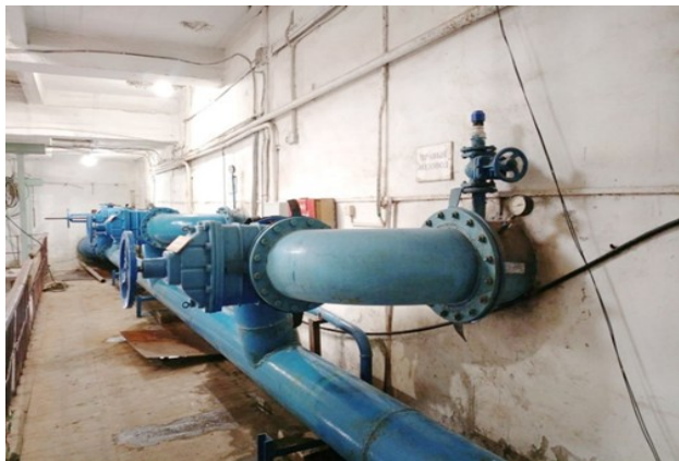
Рисунок 6.4.2 – Коллектор водозабора
