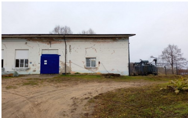
Рисунок 6.4.3 – Здание старой НС-1
