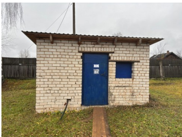
Рисунок 6.4.17 – Павильон скважины ул. Громова
